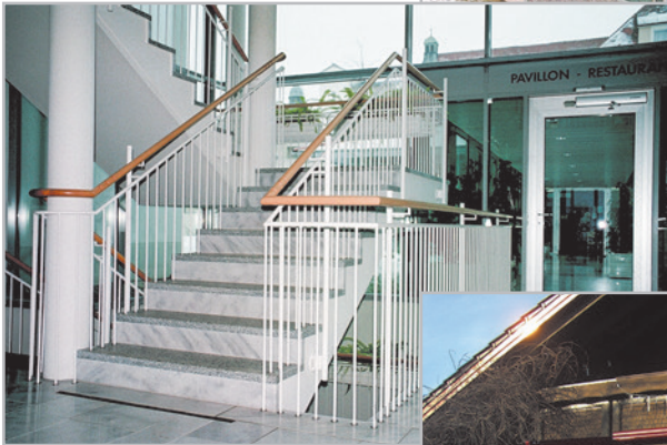
Geländer- und Treppenbau
